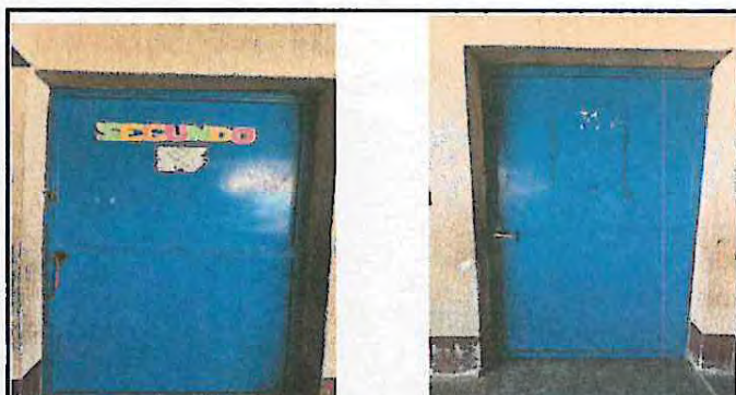
Foto 4: Mantenimiento a estructura
