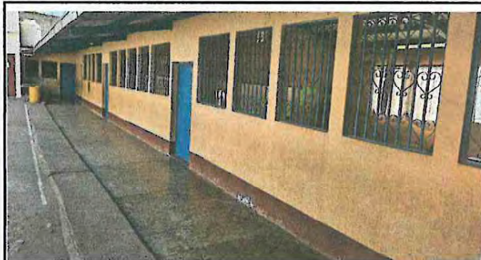
Foto 2: Pintura en muros exteriores e interiores
