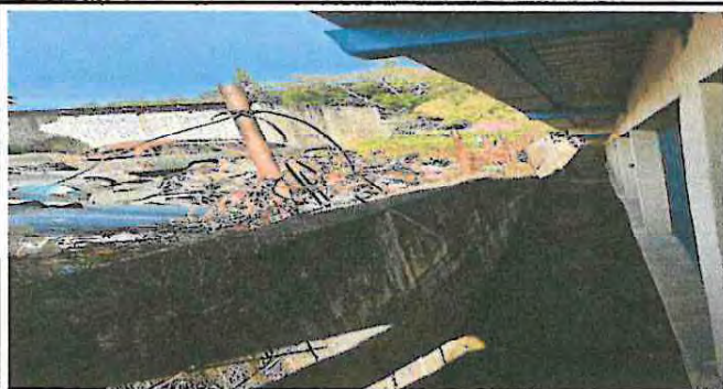
Foto1: Reparación de tubo hg y malla galvanizada
