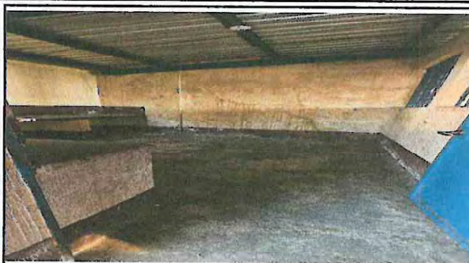
Foto 2: Instalación de planchas de metal
