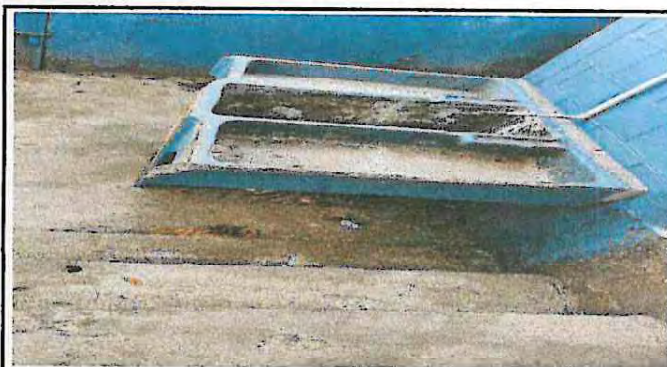
Foto 4: Instalación de pila
