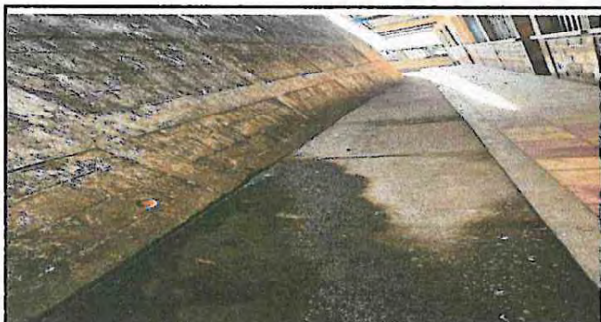
Foto 3: Sustitución de tubería pvc línea principal de agua pluvial
